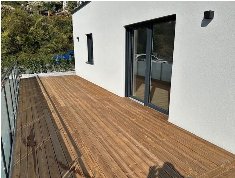
Terrasse richtung West
